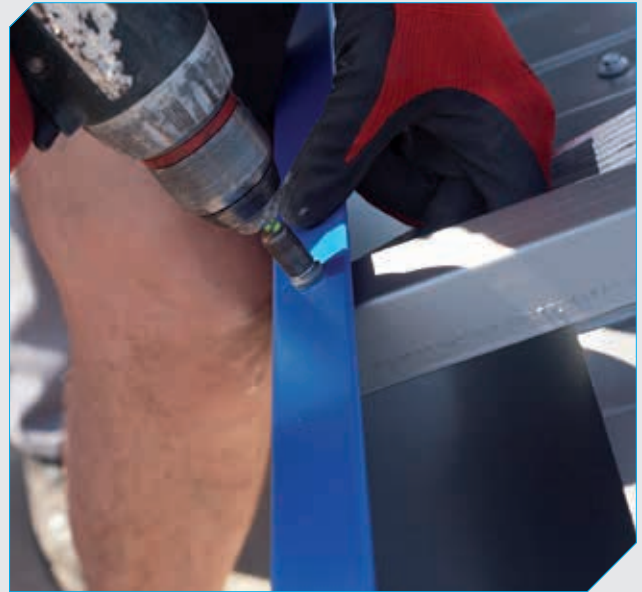
Befestigung der Rinne am zuvor aufgeschraubten Halter
