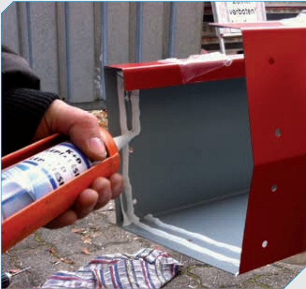
14) Kleber auftragen (beidseitig der Löcher)
